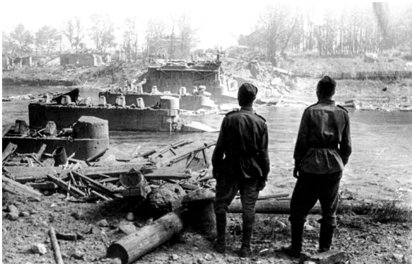
Красноармейцы стоят у Нарвского моста, взорванного отступающей немецкой армией. Город Нарва, Эстонская ССР. Июль 1944 г. Источник изображения: https://waralbum.ru
